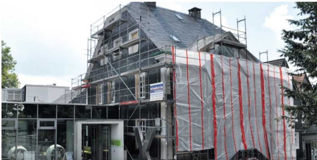
Das Haus Oelbermann, Teil des Röntgen-Museums, bleibt noch mindestens bis Herbst eingerüstet. Foto: am
