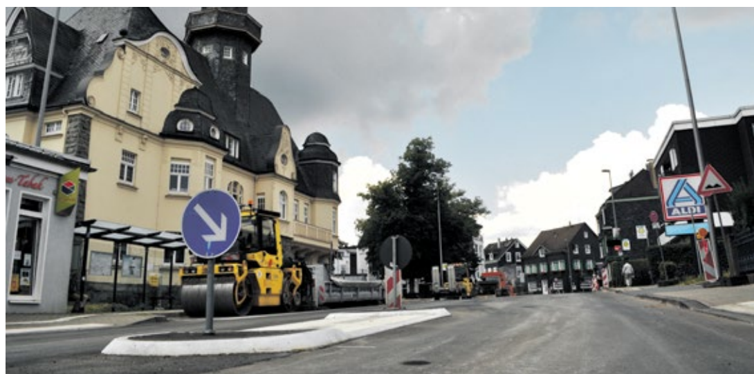
Letzte Baustellenaufnahme. Seit gestern ist die Kreuzbergstraße wieder befahrbar. Foto: am
