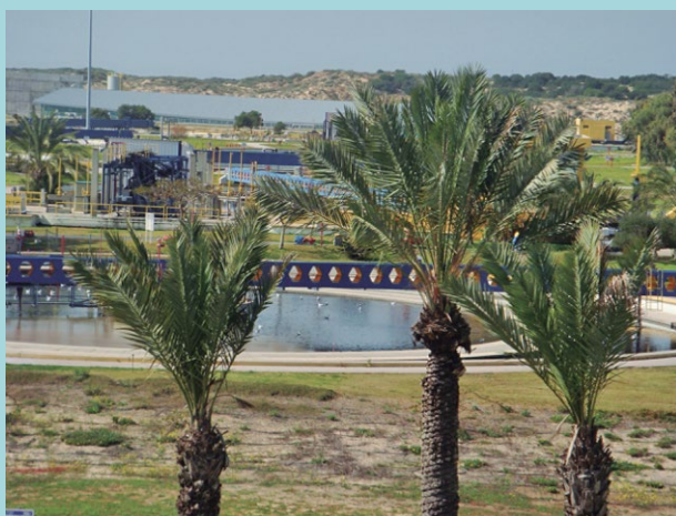
Figura 02 – Fotografia da Estação de Tratamento de Esgotos Shafdan em Tel Aviv (Israel) Fonte: Acervo próprio (Eng. Mishelle, operadora de Shafdan)
